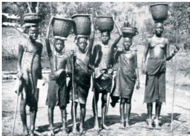
6. kép: Ebéd érkezett a hídépítő munkásoknak. A kép forrása: Thanhoffer Lajos 1943, 49.
